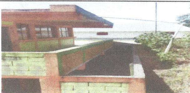
Foto 3: pintura en muros exteriores e interiores
