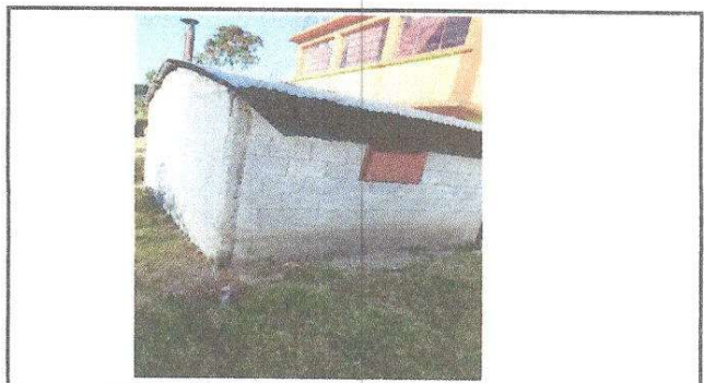
Foto 10: repello en muro
