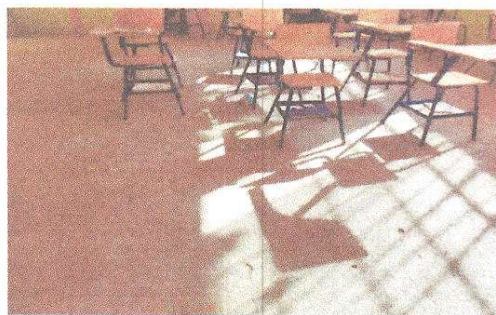
Foto 2: sustitución de Piso de Cerámico
