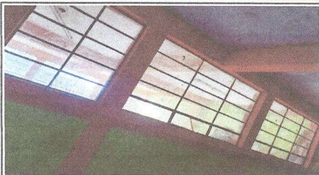
Foto1: sustitución de balcones de metal
