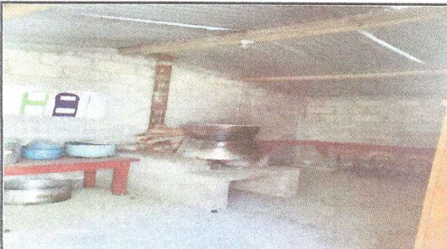
Foto 9: repello en muro
