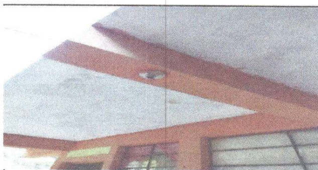
Foto 6: Sustitución de plafoneras
